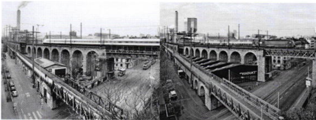
IM Viadukt, before and after
