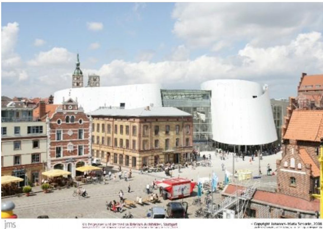
Fig 05: The Ozeaneum Source: Behnisch Architekten, 2010
